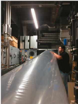
Dichtstoff wird zerstäubt und strömt in den Luftkanal
