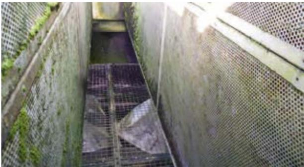
„Hygienefalle“: Dach-Schalldämpfer eines Kühlturms.
