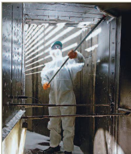
Abb. 3: Reinigung Zuluftkanal.
