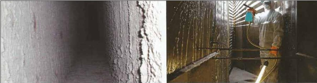
Deutliche Verschmutzung in einem Luftleitungssystem.
