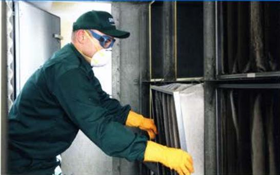
Ausbau verschmutzter Filter
