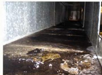
Deutliche Verschmutzung in einem Luftleitungssystem
