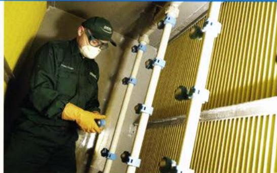
Montage der Sprühköpfe nach der Reinigung
