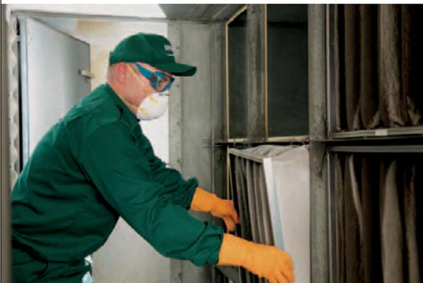
Luftfilter halten Staub von der Lüftungsanlage fern. Das funktioniert nur, wenn sie regelmäßig kontrolliert und ausgetauscht werden.
