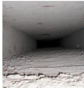
Ein stark verschmutzter Luftkanal.
