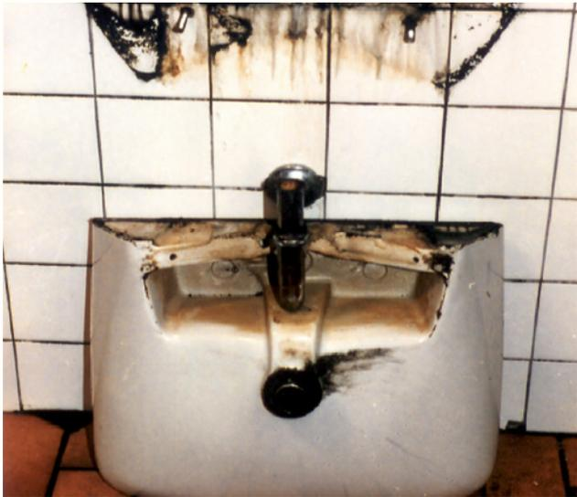
Starke Verunreinigung der Wandanlagefläche, der Unterseite und Rückseite eines Waschbeckens.
