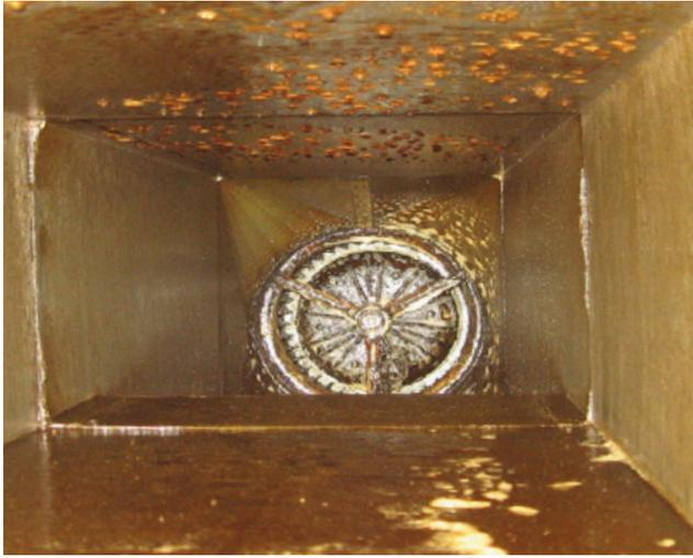
Erhebliche Fettablagerungen in einer Küchenabluftleitung und an einem Abluftventilator.
