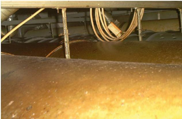
Erhebliche Fettablagerungen in einer offenen Lüftungsdecke.
