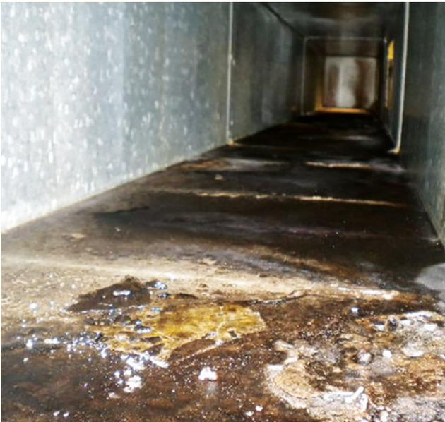
Deutliche Verschmutzung in einem Luftleitungssystem.
