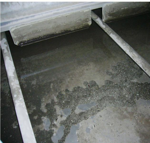
Starke Biofilm- und Kalkablagerungen in der Umlaufwanne eines Kühlturms.
