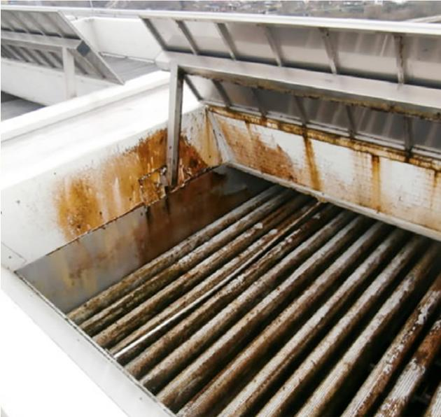
Starke Ablagerung am Abflutauslass eines Rückkühlwerkes.
