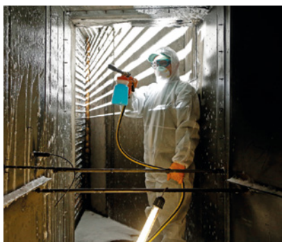
Auch der Luftkanal wird gründlich gereinigt und gegebenenfalls desinfiziert.
