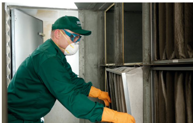
Die Reinigung dieser Filterkammer wird vom Spezialisten der Gesa Hygiene-Gruppe übernommen.
