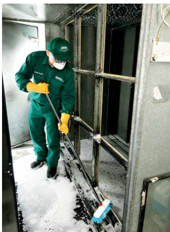
Die regelmäßige Reinigung der raumlufttechnischen Anlage legt die Basis für einen guten betrieblichen Hygienestatus. Mit der Neufassung der VDI 6022 ist die vergleichende Luftkeimuntersuchung verpflichtend geworden.
