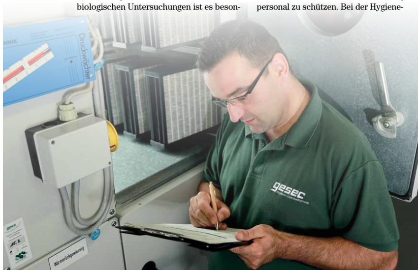
Bei der Inspektion einer RLT-Anlage wird dokumentiert, ob optische, mikrobiologische oder konstruktive Mängel vorliegen
