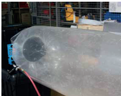
Dichtstoff wird in den Luftstrom eingeleitet.
