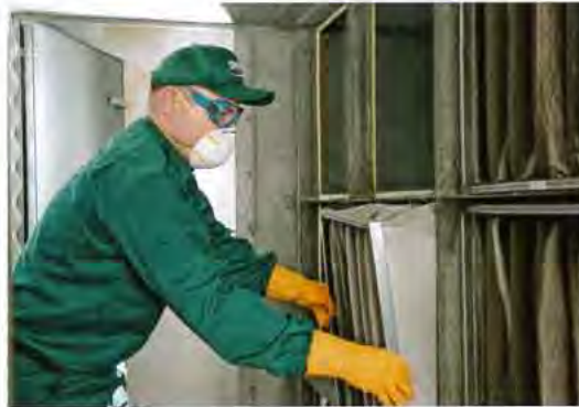
Ausbau verschmutzter Filter
