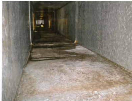
Luftleitungssystem nach der hygienisch-technischen Behandlung
