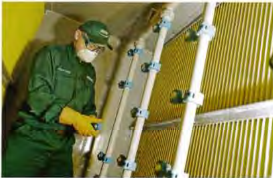
Montage von Sprühköpfen nach der Reinigung
