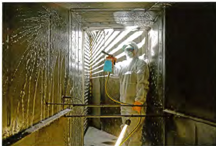
Ausbringung der Reinigungsflotte in einem verschmutzten Lüftungskanal
