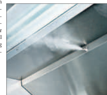
Über Düsen sprüht Südluft Zellkulturen in den Thermikstrom der Küchenabluft, die Fette und Gerüche zersetzen. Foto: Südluft
