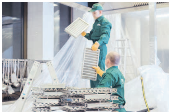
Ausbau der gereinigten Aerosolabscheider, für die hygienisch-technischen Wartung der gesamten Abluftanlage. Foto: Gesec
